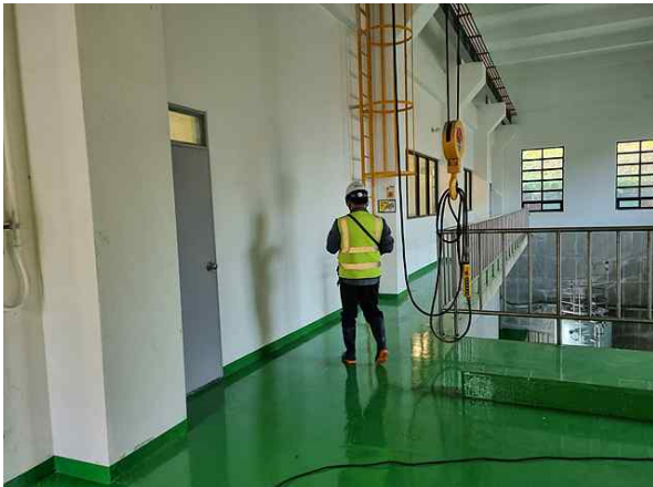
<내부 개별부재 외관조사>
