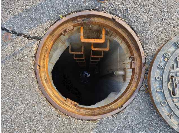
<유량계실 출입구 전경>
