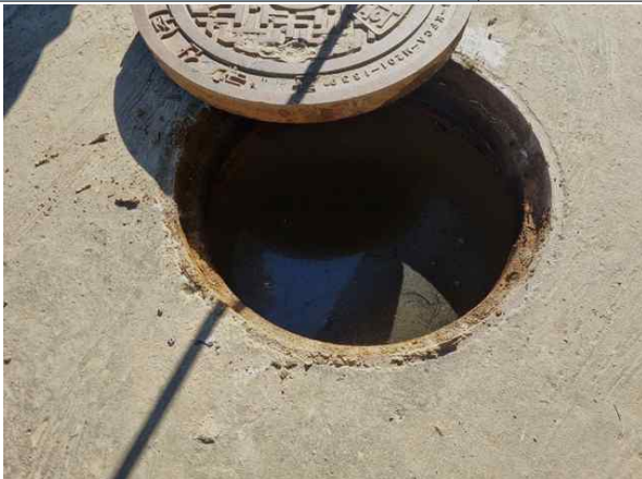
<송수-2 Sta.34+13.2(이토) 만수>
