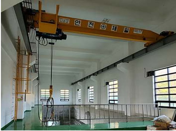
<펌프실 호이스트 상태양호>
