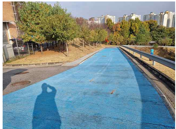
<송수-3 (Sta.0+14.7) 포장 상태양호>
