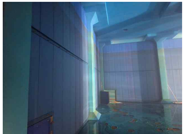
<배수지 2지 도류벽 상태양호>
