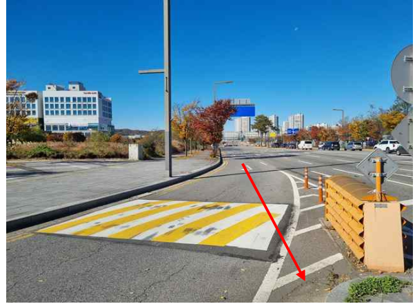
<송수-1,2 (Sta.17+3.1) 포장 및 지반 상태양호>
