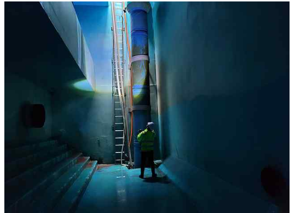
<내부 개별부재 외관조사>
