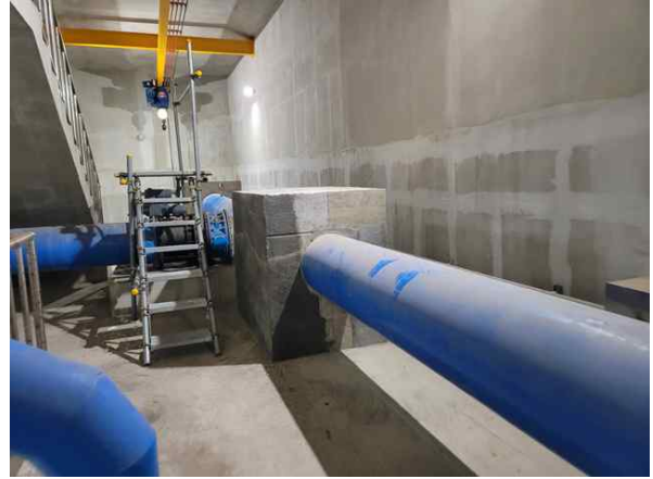
<3~4호지 유입밸브실 배관받침 상태양호>
