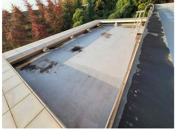
<건축물 옥상 방수층, 파라펫 상태양호>
