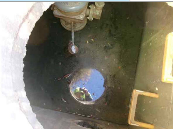
<송수-5 Sta.11+5.2(공기) 구조물 및 밸브 상태양호>
