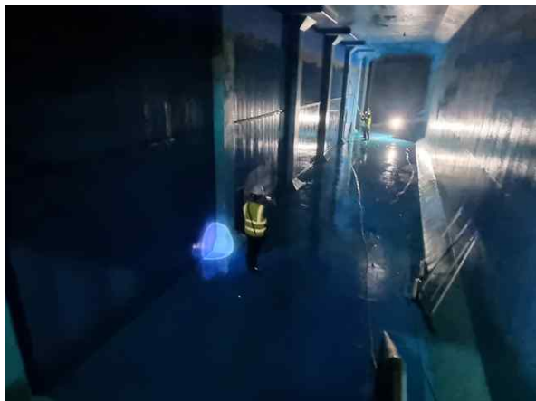
<내부 개별부재 외관조사>
