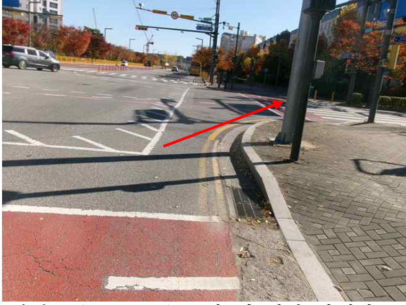
<송수-6(Sta.0+0.0) 포장 및 지반 상태양호>
