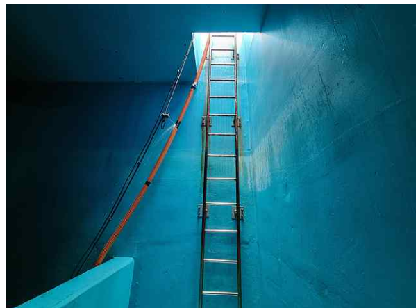
<배수지 1지 점검사다리 상태양호>
