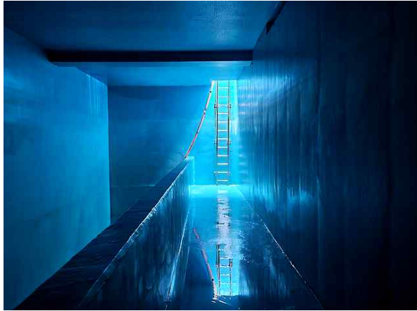
<저류조 및 흡수조 1지 내부 전경>
