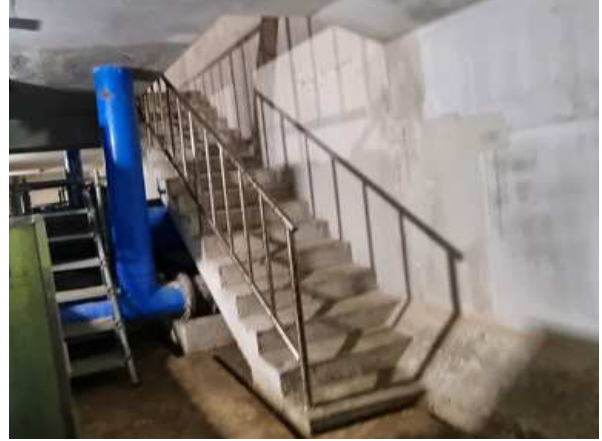
<1~2호지 유출밸브실 계단 난간 상태양호>
