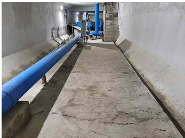
<3~4호지 유출밸브실 상부슬래브 전경>
