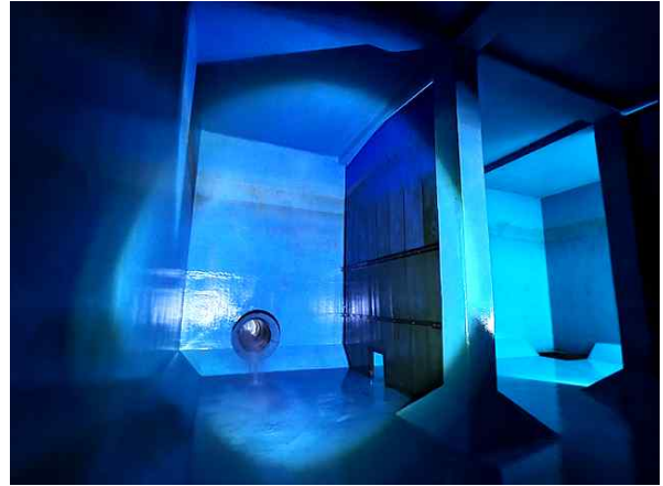
<저류조 및 흡수조 2지 내부 전경>
