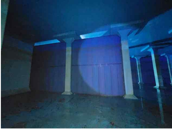
<배수지 1지 도류벽 상태양호>
