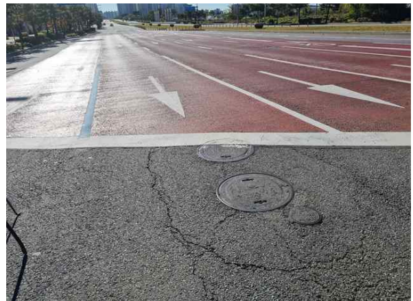
<송수-2 이토밸브실 맨홀 덮개 상태양호>
