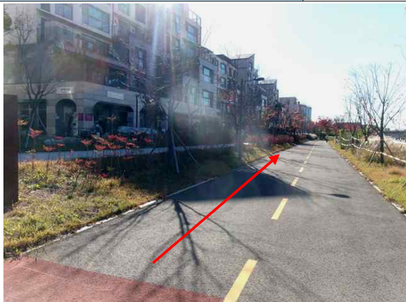
<송수-4, 5 (Sta.282+0.0, Sta.3+10.0) 포장 및 지반 상태양호>
