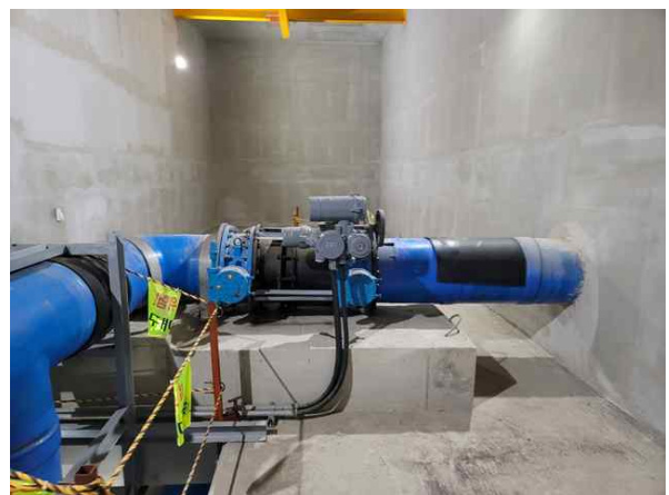
<3~4호지 유입 밸브, 배관, 볼트류 상태양호>
