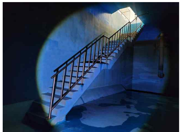
<배수지 3지 출입계단 및 안전난간 상태양호>
