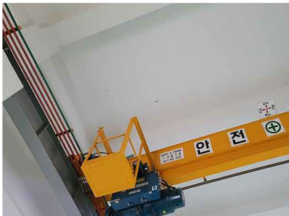
<펌프실 지상1층 상부슬래브 누수흔적>
