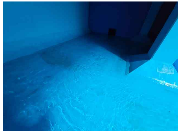
<배수지 1지 바닥슬래브 상태양호>
