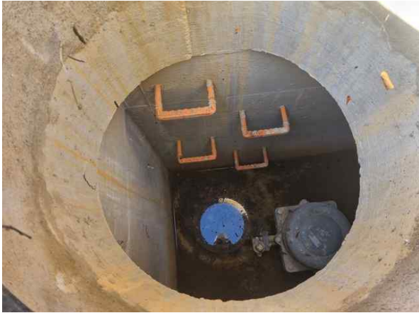
<송수-1 공기밸브실 사다리 설치 상태양호>
