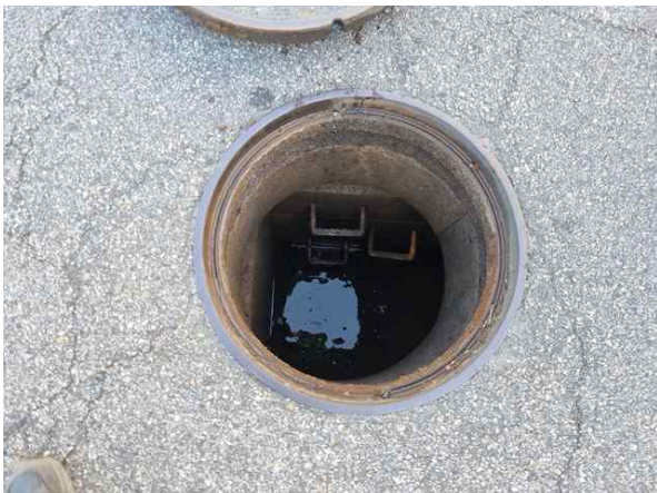
<송수-2 제수밸브실 사다리 설치 상태양호>
