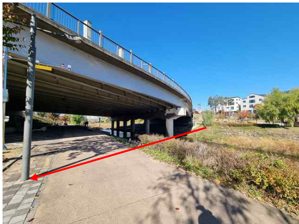
<송수-1, 2 (Sta.66+1.0) 포장 및 지반 상태양호>
