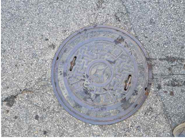
<송수-2 제수밸브실 맨홀 덮개 상태양호>
