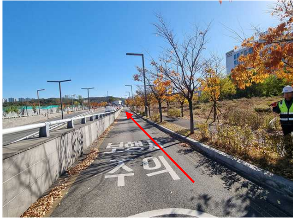
<송수-1, 2 (Sta.1+0.0) 포장 및 지반 상태양호>
