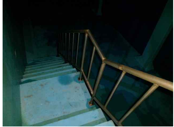
<배수지 4지 출입계단 및 안전난간 상태양호>
