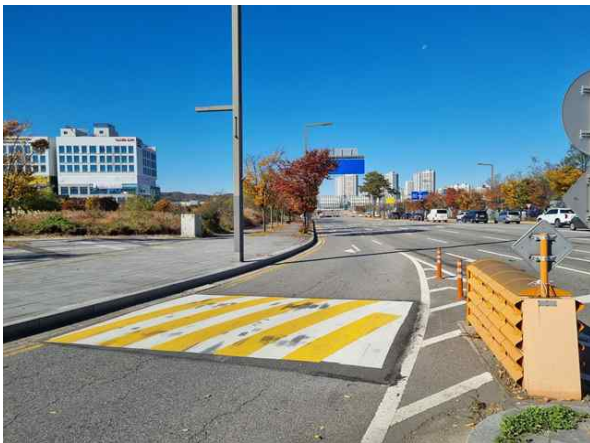
<송수-1, 2 (Sta.17+3.1) 포장 상태양호>
