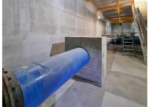
<1~2호지 유입밸브실 배관받침 상태양호>
