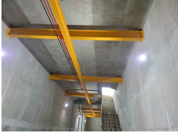
<3~4호지 유입밸브실 상부슬래브 전경>
