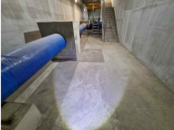
<1~2호지 유입밸브실 바닥슬래브 상태양호>
