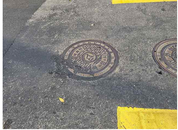
<송수-3 이토밸브실 맨홀 덮개 상태양호>
