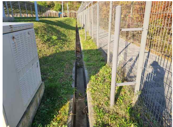
<측구 배수로 전경>
