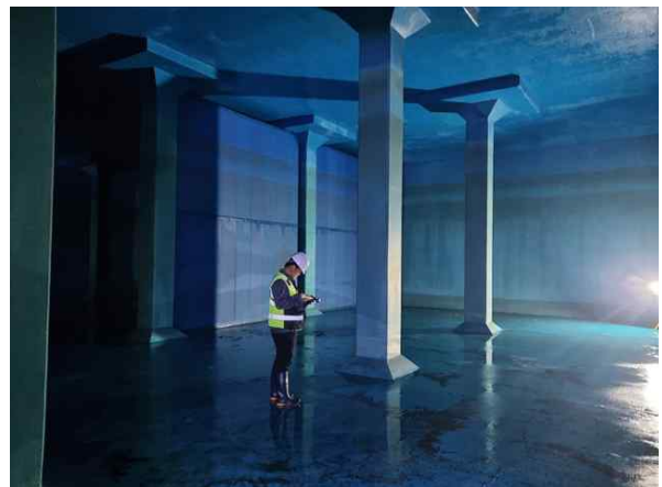
<내부 개별부재 외관조사>
