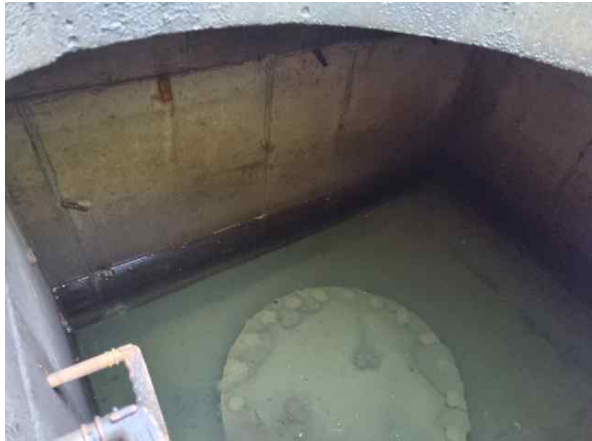
<송수-2 Sta.49+13.3(제수) 구조물 및 밸브 상태양호>
