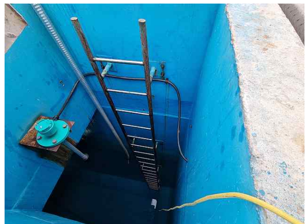
<배수지 2지 점검사다리 상태양호(2구역)>
