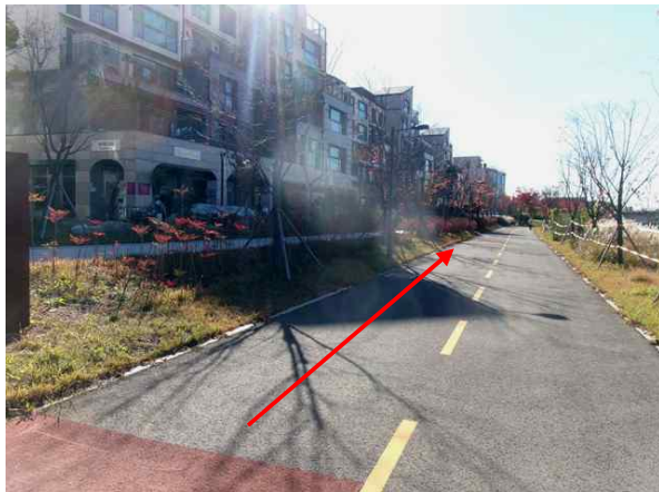
<송수-4, 5 (Sta.282+0.0, Sta.3+10.0)>
