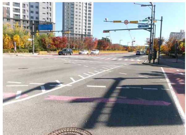
<송수-6 (Sta.0+0.0) 포장 상태양호>
