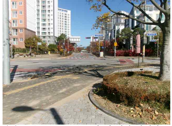
<송수-6 (Sta.14+17.0) 포장 및 지반 상태양호>
