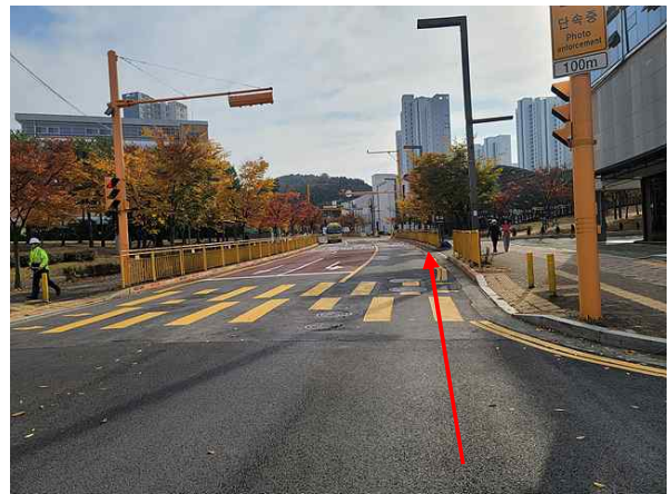
<송수-3 (Sta.10+14.3) 포장 및 지반 상태양호>
