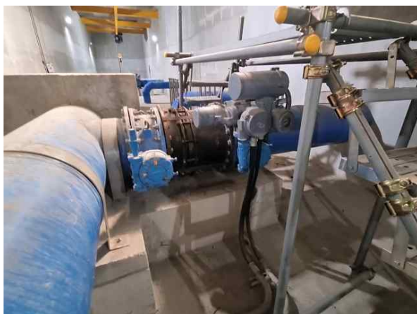
<1~2호지 유입 밸브, 배관, 볼트류 상태양호>
